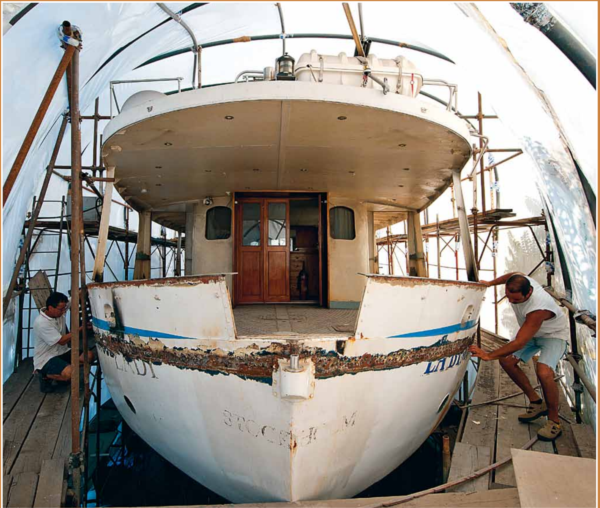
Pagina a lato: si lavora alacremente sul ponte di America per consentirle di prendere il mare al più presto. Matteo Toninelli, il direttore generale di America srl , è in continuo contatto con il cantiere. La goletta oggi è diventata una location esclusiva per spot pubblicitari ed eventi. Qui sopra: lavori di refitting per Lady .
